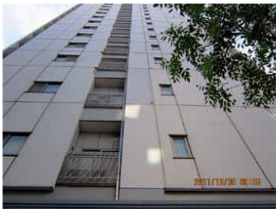
【写真1】 改修前：コンクリート落下の状態を示す
