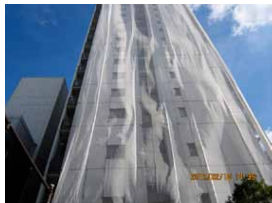
【写真2】 改修中：足場は移動足場を使用している
